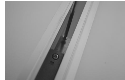
Vast schroeven van de softclosing in de bovenrails Zijkant softclosing tot schuifdeur is 85 mm
